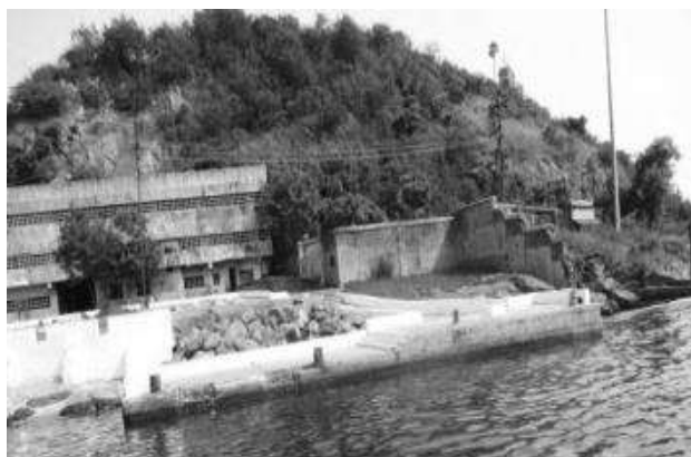
A. HSL Ferry Jetty
