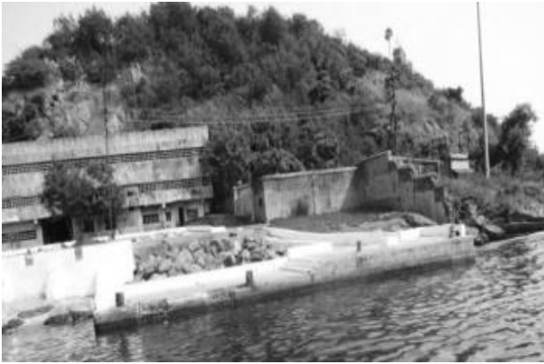
A. HSL Ferry Jetty
